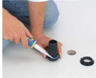
2. Dichtklebemasse auf den Stützen der Dachdurchführung auftragen. Stützen in die Bohrung einführen und von unten mit der Rändelmutter fixieren.
